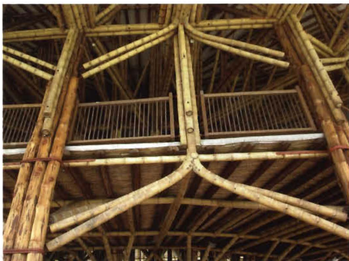
Figura 3. Uso del rizoma y la cepa como elemento estructural (Recinto del Pensamiento), Manizales-Colombia
